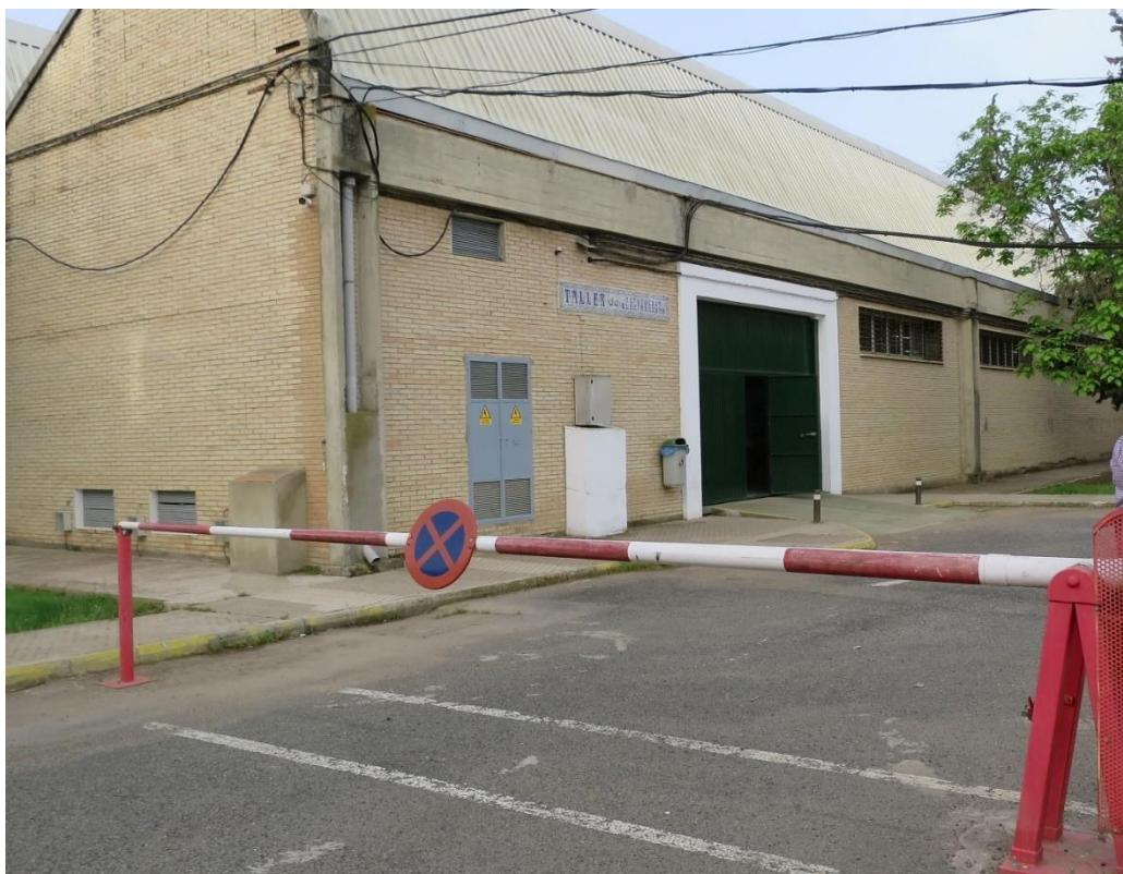
Barrera de entrada al EDI-9 y cables aéreos
